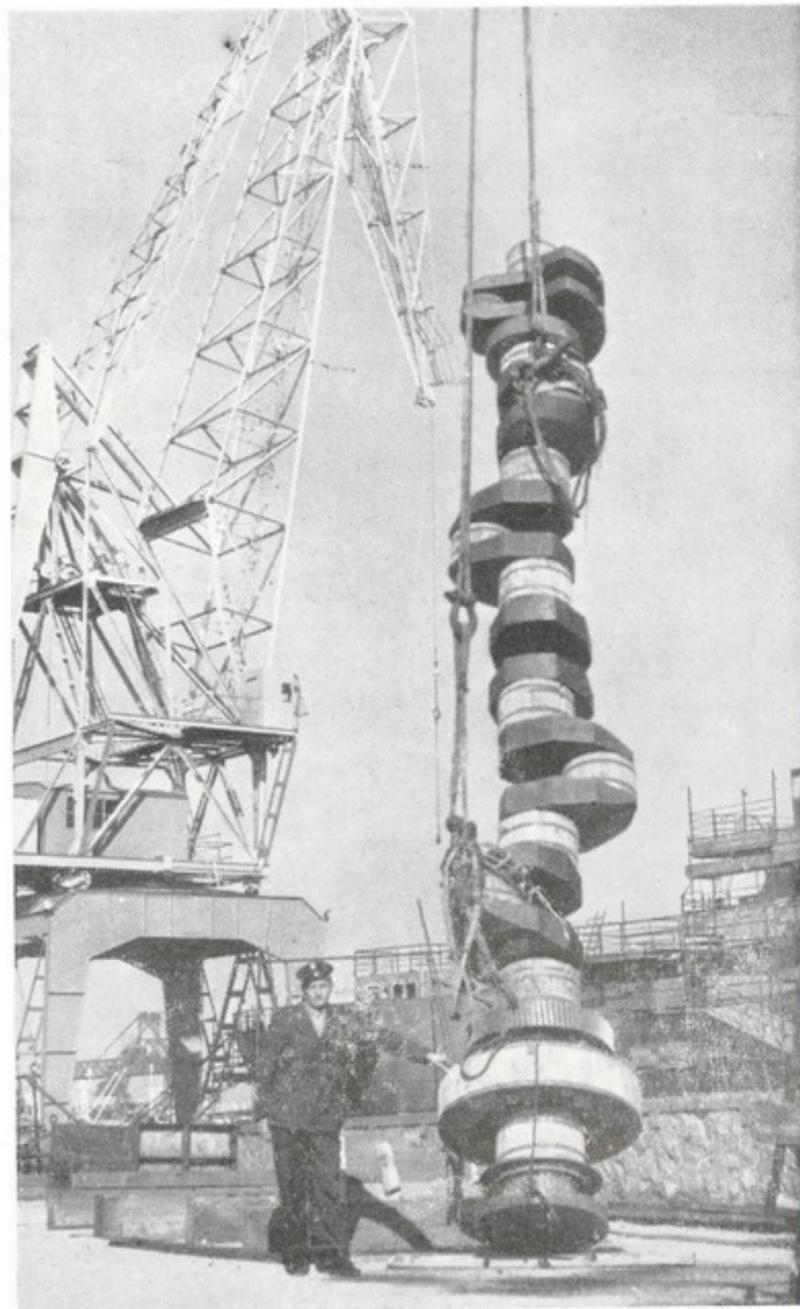
L'albero a manovelle destinato all'apparato motore della motonave « Brennero », mentre viene sollevato dalla gru per essere collocato a bordo della nave in allestimento
